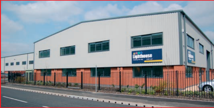
Lighthouse (UK) Ltd. Productiefaciliteit voor verbruiksartikelen
